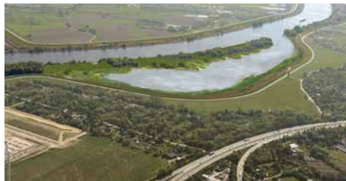
So soll das ehemalige Spülfeld Kreet sand nach Abschluss der Bauarbeiten aussehen
